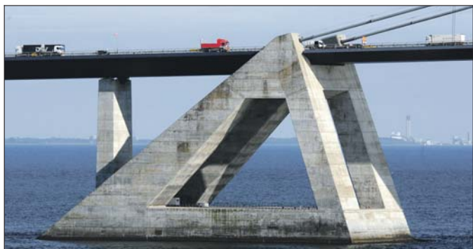
Ein Stützpfiler für Dänemarks Binnenverkehr ist die Großer-Belt-Brücke zwischen Seeland und Fünen. Deswegen ist ihre Maut mittlerweile auch heftig umstritten.
